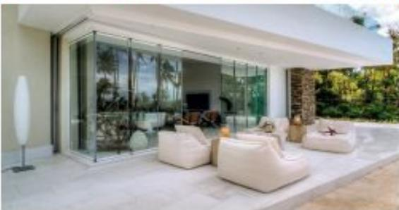
**Funcionamiento:** En primer lugar se abre la primera hoja de vidrio hacia el interior. A continuación, se deslizan una a una el resto de hojas hacia el lado de apertura y se abaten hacia el interior. Empuje o tire del borde del vidrio para ayudar a la hoja a deslizarse sin problemas. Este sistema proporciona una forma cómoda de ganar espacios.
